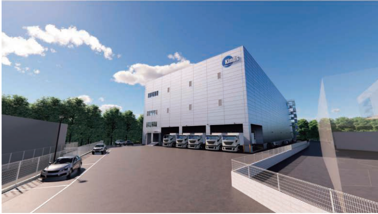
2022年竣工予定の新センターです。
